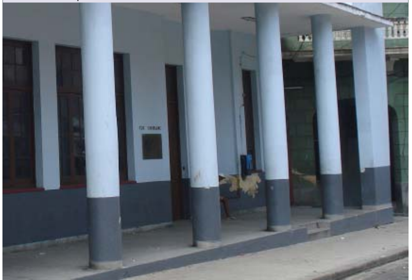
Este era el aspecto de la fachada del inmueble.
